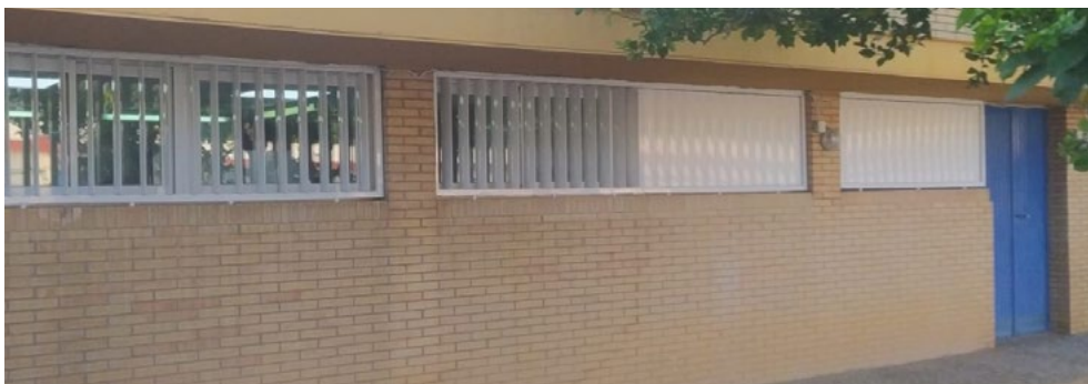
El Torreblanca, Sevilla. Sustitución de ventanas y plantación de árboles
