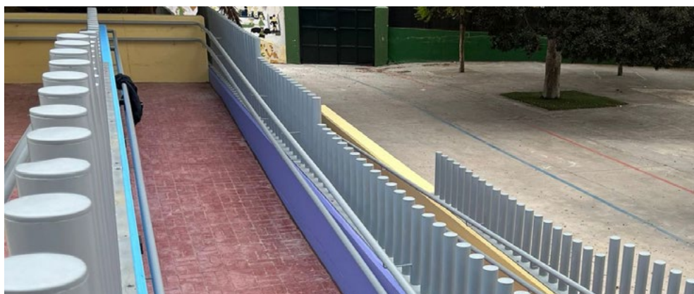
CEIP Miguel de Cervantes, Marbella (Málaga). Eliminación de barreras arquitectónicas
