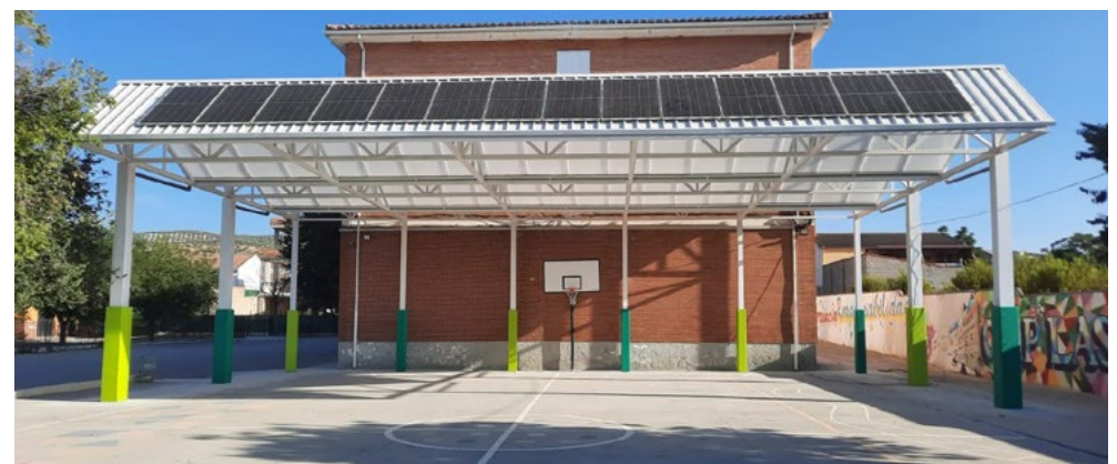
CEIP Las Alhomas, Pinos Puente / Zujaira (Granada). Bioclimatización con instalación de energía fotovoltaica
