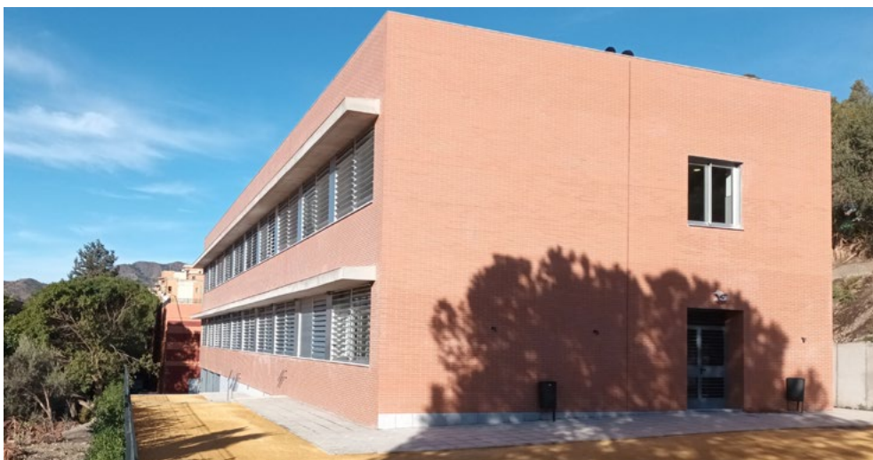
IES Martín de Aldehuela, Málaga. Ampliación y reforma de espacios educativos para ciclos formativos
