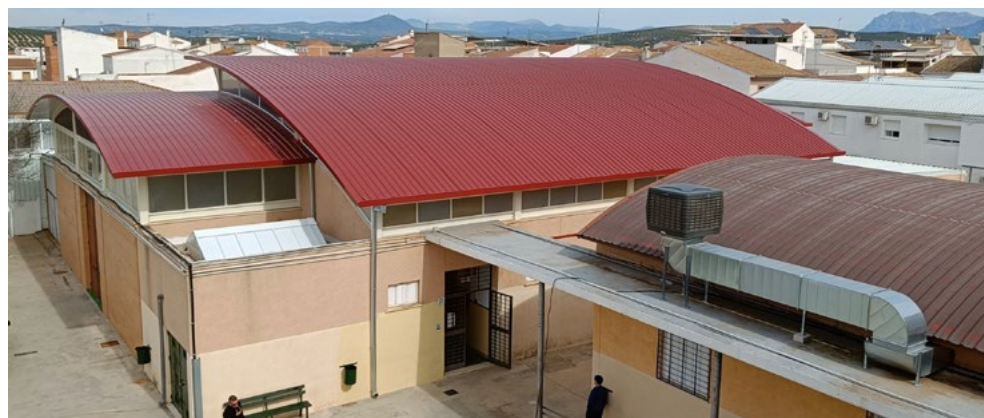
IES Don Diego de Bernuy, Benamejé (Córdoba). Reparación de cubierta en gimnasio y aseo vestuario
