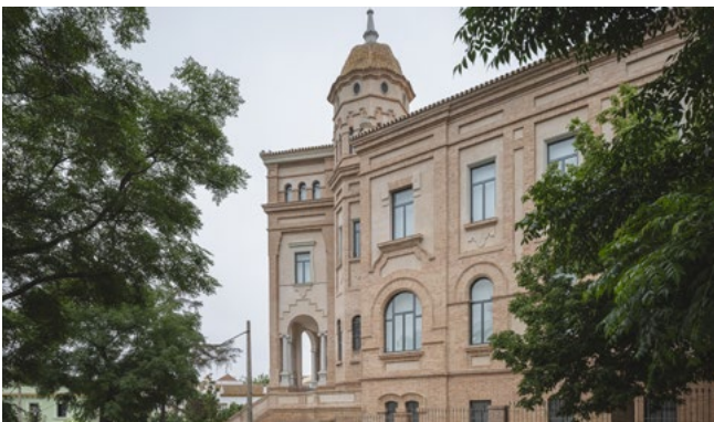
Reforma integral y ampliación del IES La Rábida de Huelva
