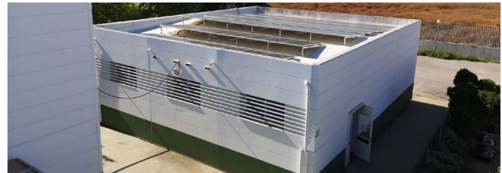
CEIP Montelirio, Castilleja de Guzmán (Sevilla). Bioclimatización con instalación de energía fotovoltaica
