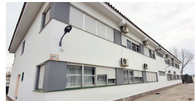
CEIP Guadalete, Jerez de la Frontera / El Torno (Cádiz)
