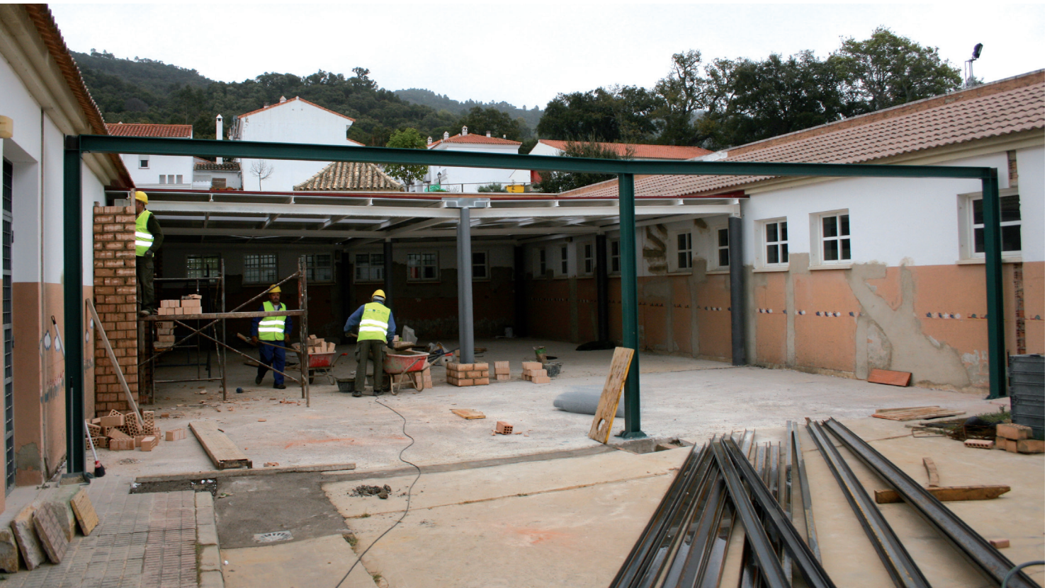
Obra de adaptación de espacios en el CPR Tresfuentes de Alájar.
