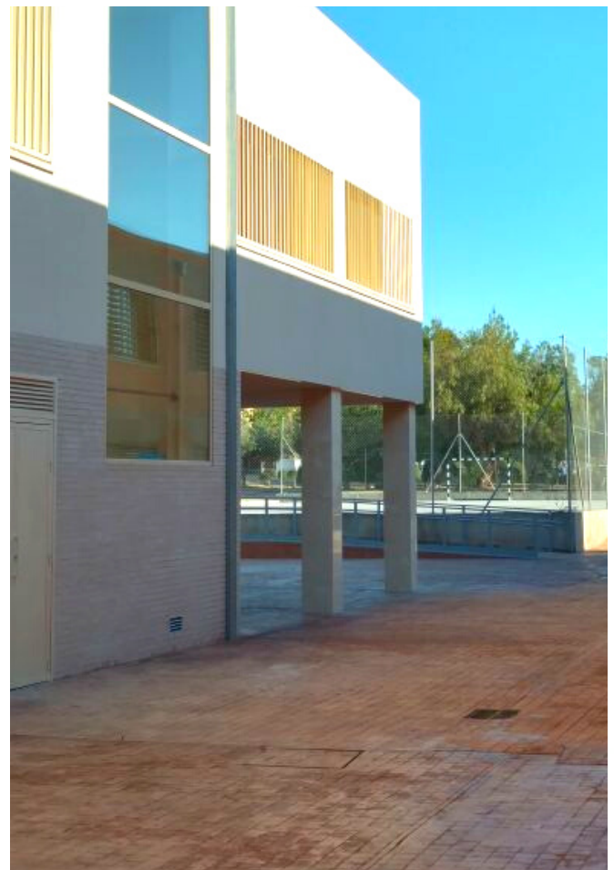
Ampliación del IES Cura Valera de Huércal Overa (Almería)
