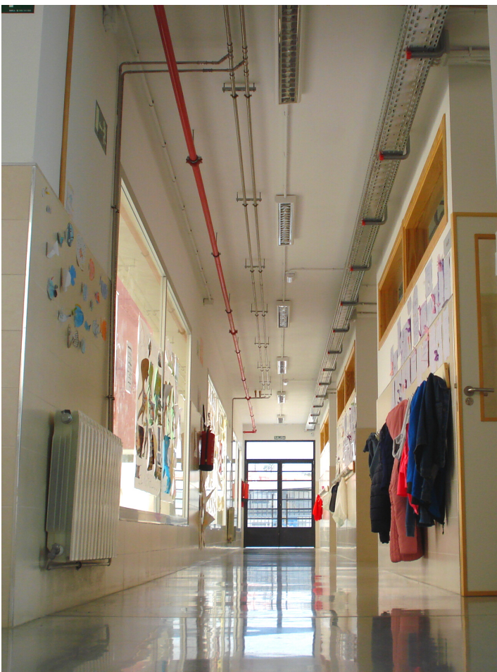
Ampliación del CEIP Blanca de los Ríos de Algeciras (Cádiz)
