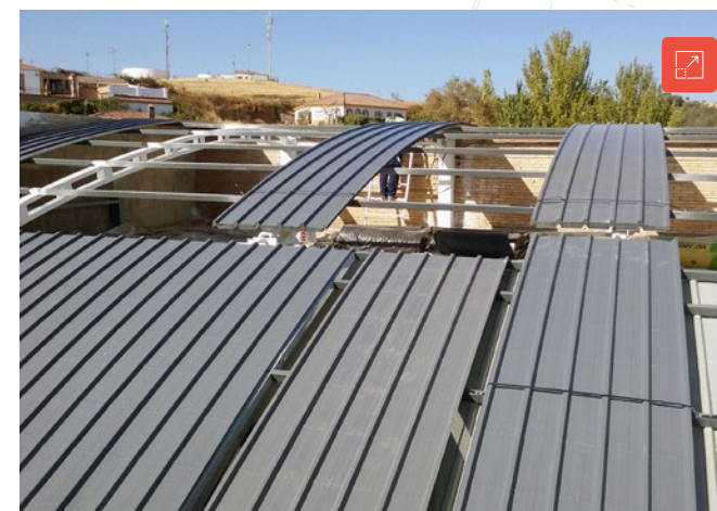
Obra de retirada de cubiertas con fibrocemento en un centro educativo.
