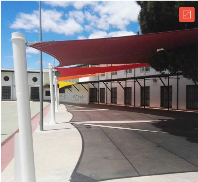
Obra de instalación de elementos de sombra en el patio de un centro escolar.
